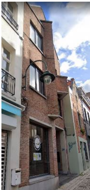
Niet-naleving van het BBP (materialen en architectuur) - Vossenstraat 22
